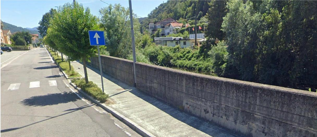
**Figura 5-1 – Analogo intervento di argine in muratura lungo la via Verdi, a monte dell’area di intervento**
