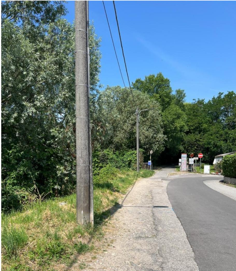
**Figura 4 – pali di pubblica illuminazione e di sostegno linea elettrica e telefonica**
