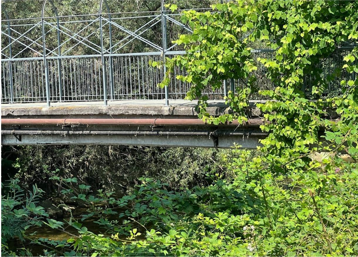
**Figura 27 – tubazioni gas e linea elettrica in corrispondenza della passerella pedonale**
